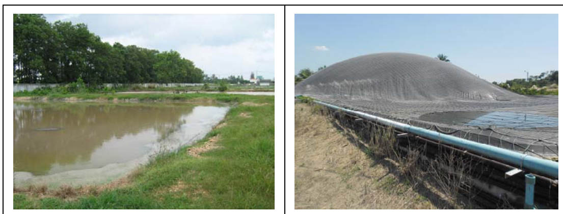
รูปที่ 5-13 ระบบบ่อปรับเสถียรที่ไม่มีเครื่องเติมอากาศแต่บ่อต้องมีความใหญ่
