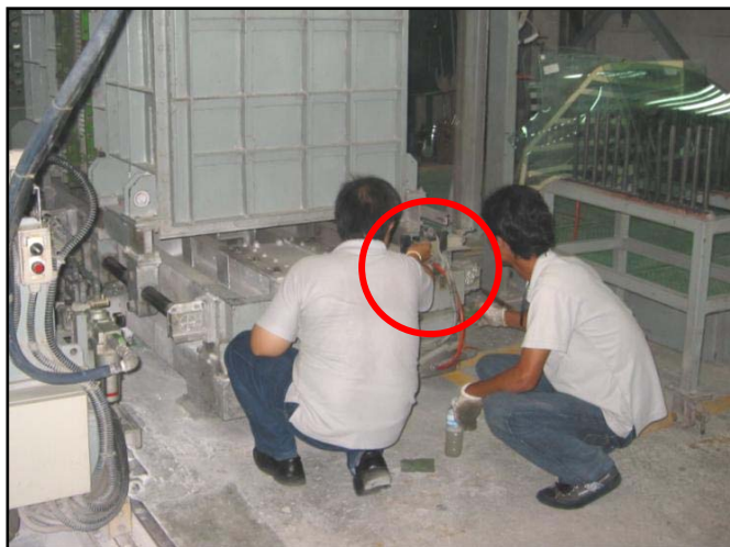
รูปที่ 3.34 แสดงการตรวจสอบจุดที่มีการรั่วของระบบอากาศอัด
