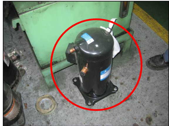
รูปที่ 3.20 แสดงเครื่องทำน้ำเย็น 20 ตันความเย็นหลังการปรับปรุง
