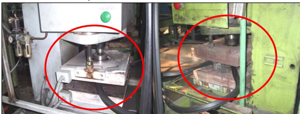
รูปที่ 3.17 แสดงสภาพการทำงานของเครื่องต่อมูมก่อนการปรับปรุง
